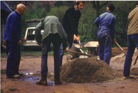
Helfer beim Bau des Kirschtal-Haus 1972
